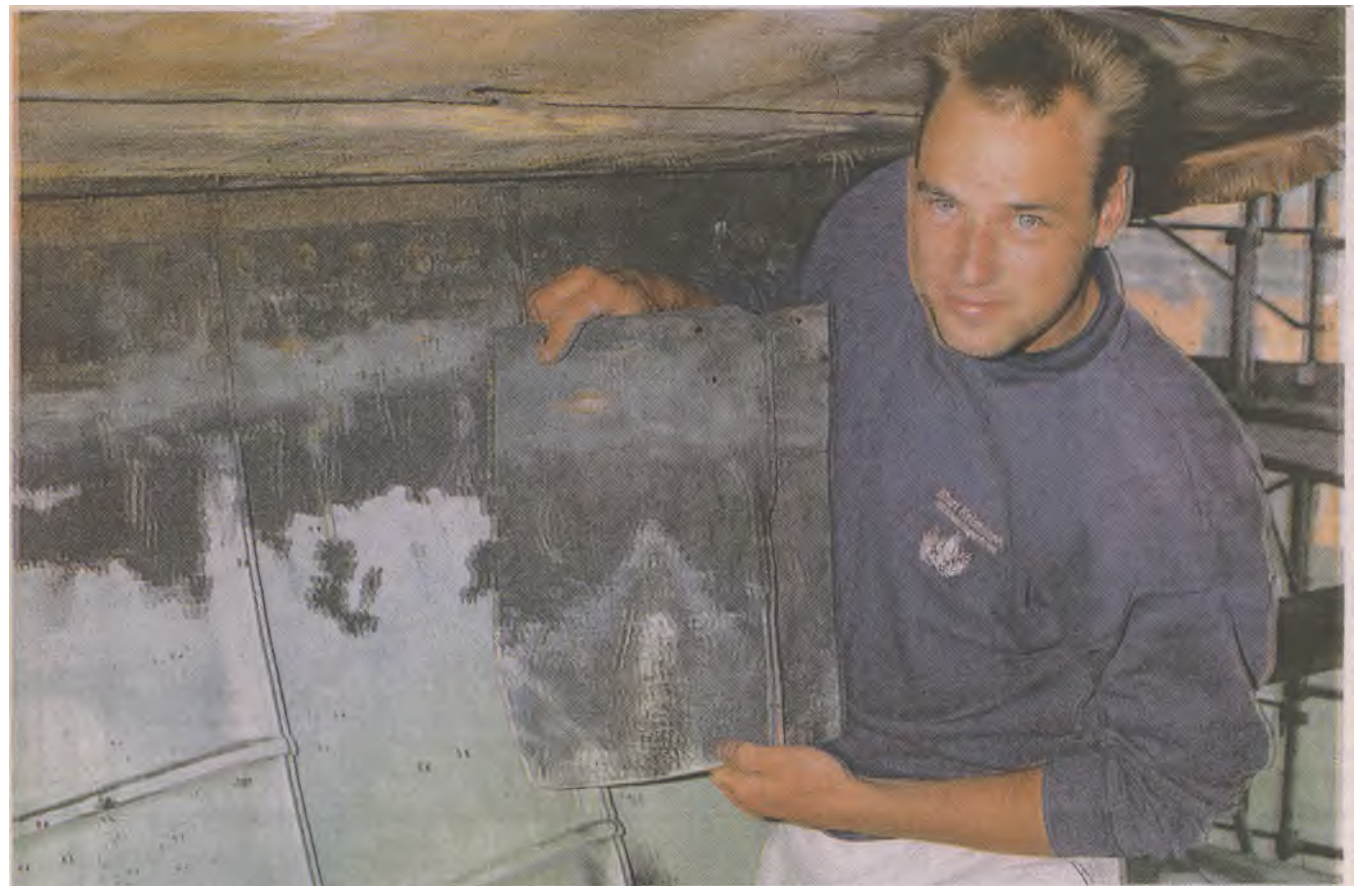
Blikkenslager Peter Mondrop viser en af de gamle kobberplader, som blikkenslagerne er ved at skifte ud. Traditionen med at ridse årstal - her 1837 - ind i pladerne, når de bliver skiftet ud, er gammel og eksisterer stadig. Således vil håndværkere i det næste par hundrede år - så længe holder det nye kobber nemlig - kunne læse, at det var i 1991, spiret sidst blev fornyet.
