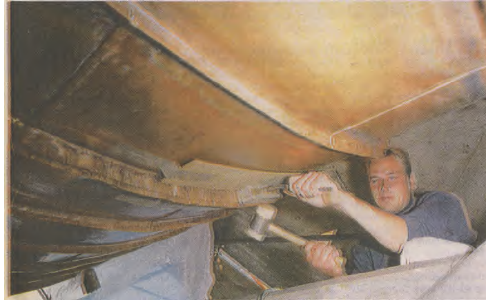
Blikkenslager Peter Mondrop viser en af de gamle kobberplader, som blikkenslagerne er ved at skifte ud. Traditionen med at ridse årstal - her 1837 - ind i pladerne, når de bliver skiftet ud, er gammel og eksisterer stadig. Således vil håndværkere i det næste par hundrede år - så længe holder det nye kobber nemlig - kunne læse, at det var i 1991, spiret sidst blev fornyet.
