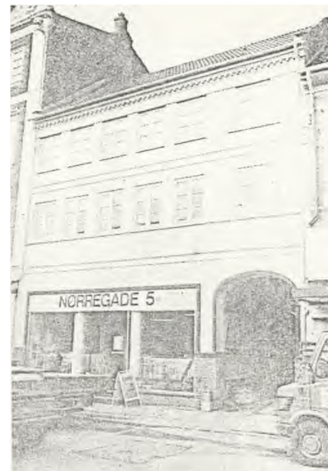
Nørregade 5 er en af de mange anonyme 1700-tals bygninger i Horsens. Læg mærke til bindingsværket, som titter frem i porten. Det var i mange tilfælde kun facaderne, som blev grundmuret og pudset.
