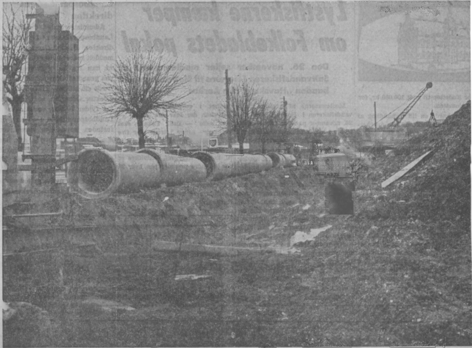
Billedet giver et ganske godt indtryk af det vældige jordarbejde og de store rør, der anvendes
