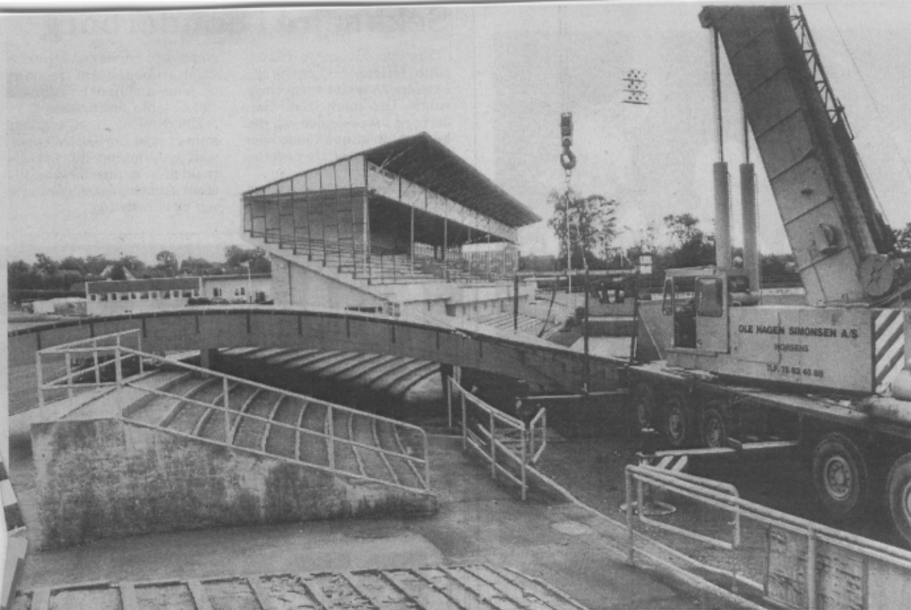
Et sidste farvel til L90. Den kæmpestore indmarchrampe i Idrætsparken er solgt til Svendborg, der vil bruge den ved Landsstævne 1994. For at kunne flytte den kæmpestore træ-rampe måtte den skæres i tre mindre stykker. Her er det 16 meter lange og knap seks meter brede midterstykke ved at blive læsset på den blokvogn, der skulle køre den til Fyn. (Foto: Lene Sørensen)
