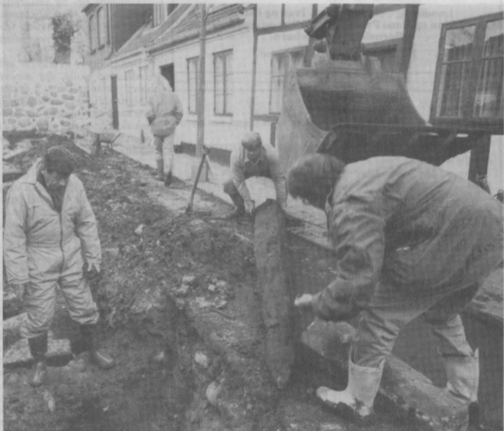
De gamle ege-stolper blev trukket op af en gravemaskine. Den længste var 3,30 meter og trods de mange hundrede år i den fugtige jord helt frisk i træet. De andre var noget mindre - og en enkelt af dem helt rådden. (Foto: Lene Sørensen)
