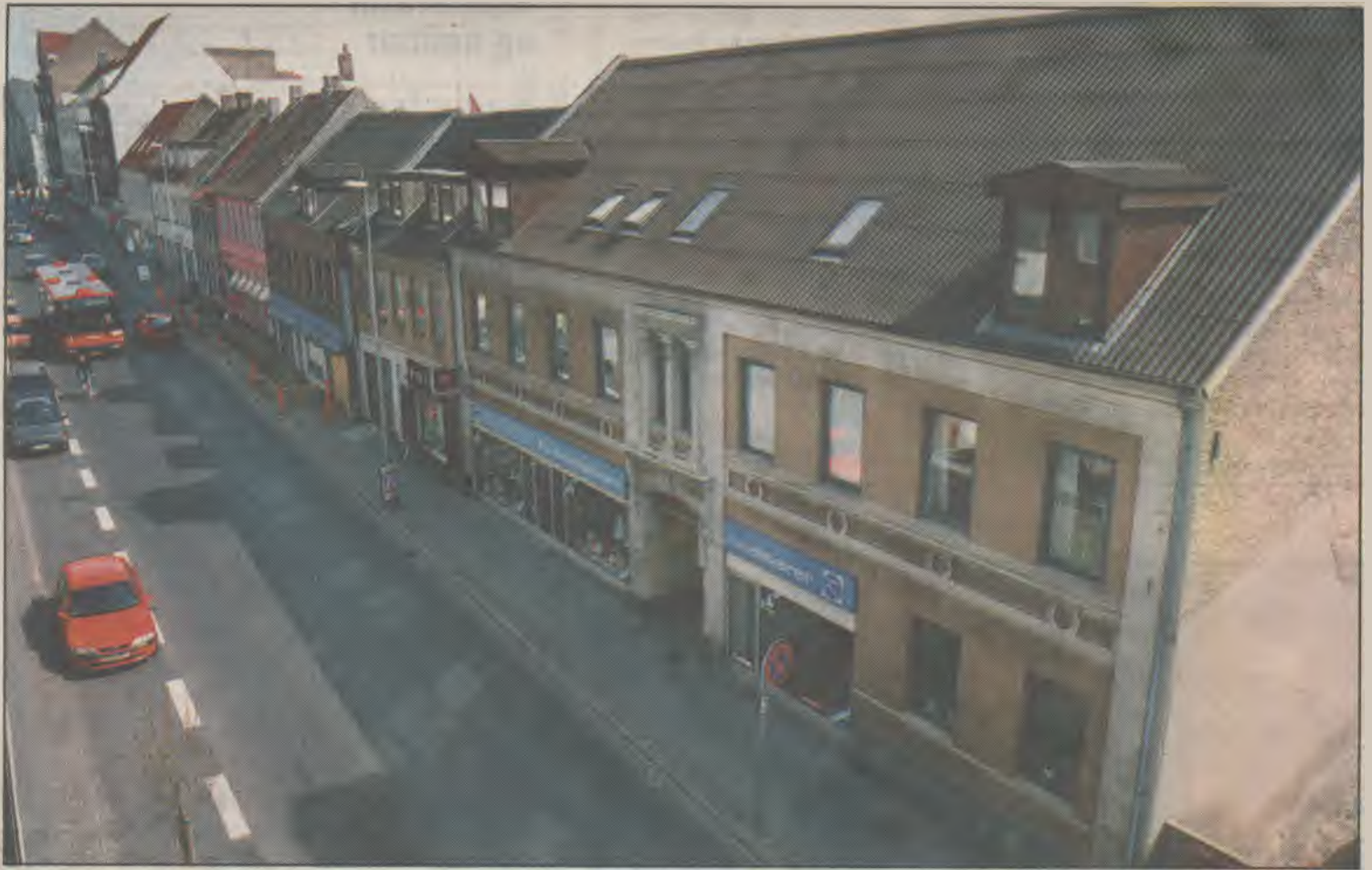
Alm. Brand. vil rive bygningerne her ned og lave midlertidig p-plads.
