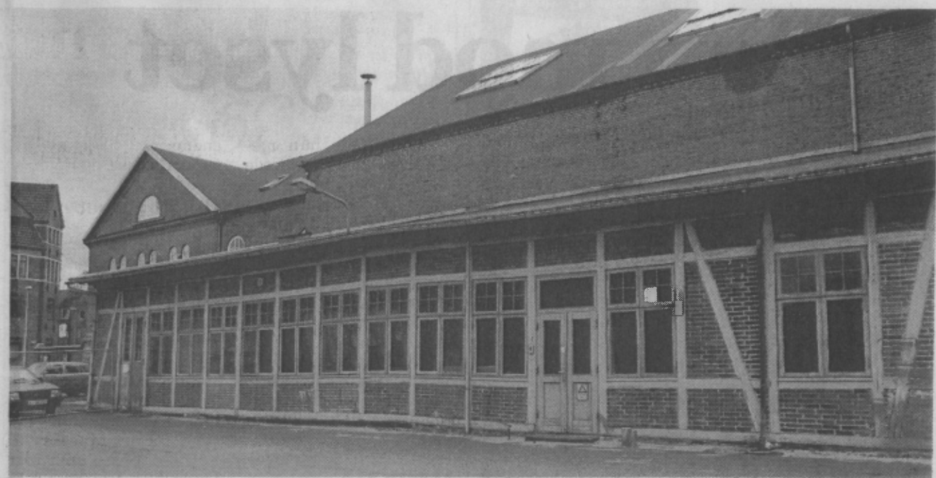
Disse smukke gamle lokaler skal indrettes med værksteder, der skal bruges i forbindelse med istandsættelse og vedligeholdelse af de hestevogne, Industrimuseet i Horsens snart overtager. Lokalerne har indtil for kort tid siden tilhørt det kommunale vand- og belysningsvæsen. Nu er de overladt Industrimuseet, hvis store bygning ses lige bagved.
