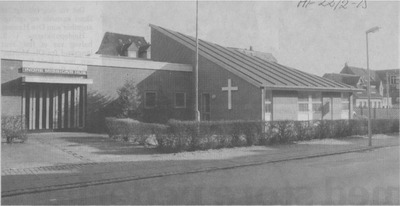
I dag råder Indre Mission i Horsens over helt moderne lokaler i Emil Bojsens Gade. Huset blev taget i brug i
