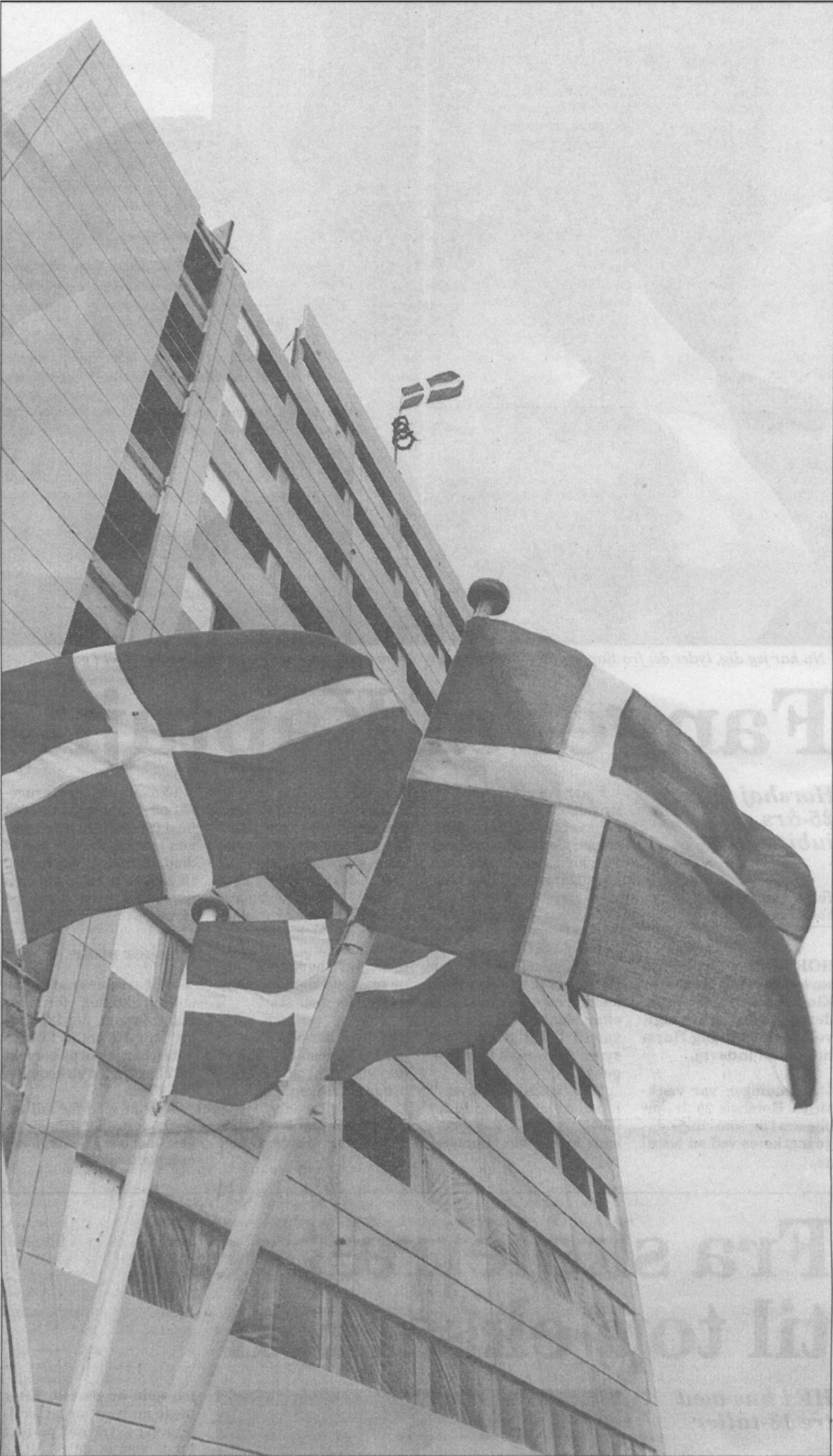
Om kort tid skyder endnu et højhus op ved siden af det ni etagers høje Horsens Uddannelsescenter, som der i går var rejsegilde på. Det kommende højhusbyggeri bliver på 12 etager, og det skal bl.a. huse Arbejdsformidlingen i Horsens.
