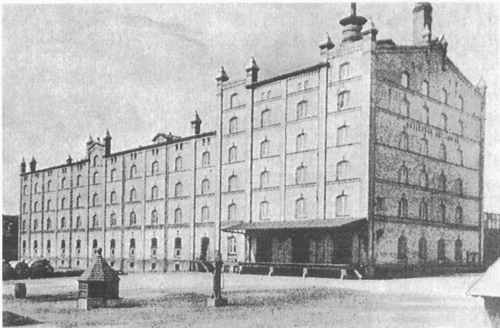
Da Horsens Malteri blev bygget i 1898, var det Danmarks største industribygning. (Foto fra 75 års-jubilæumsskrift)
