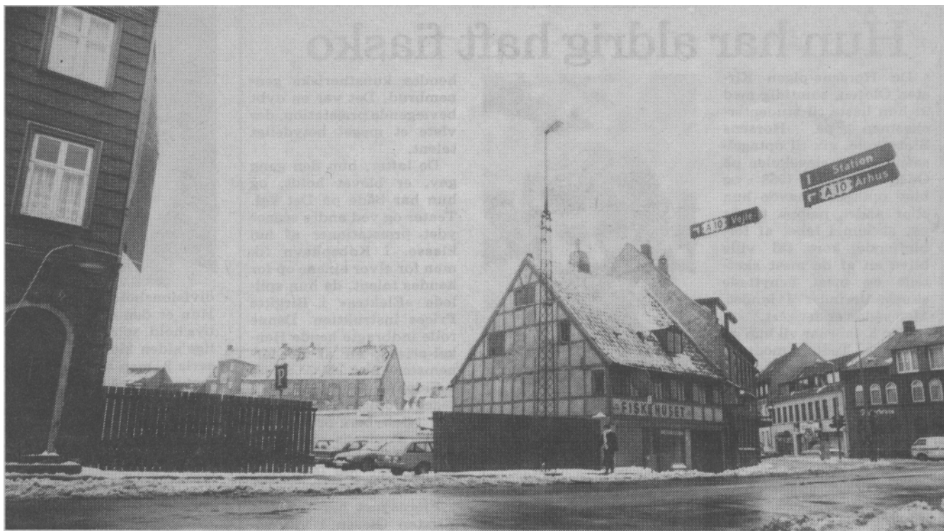
Museumsinspektør Erik Kjersgaard erklærede sig for godt et år siden interesseret i at flytte »Fiskehuset til Den gamle By - bygningen var for forsømt, og man nøjedes med at hente inventaret. Nu nedrives det gamle hus, og på tomten og nabo-grunden bygges forretningsejendom i gammel stil
