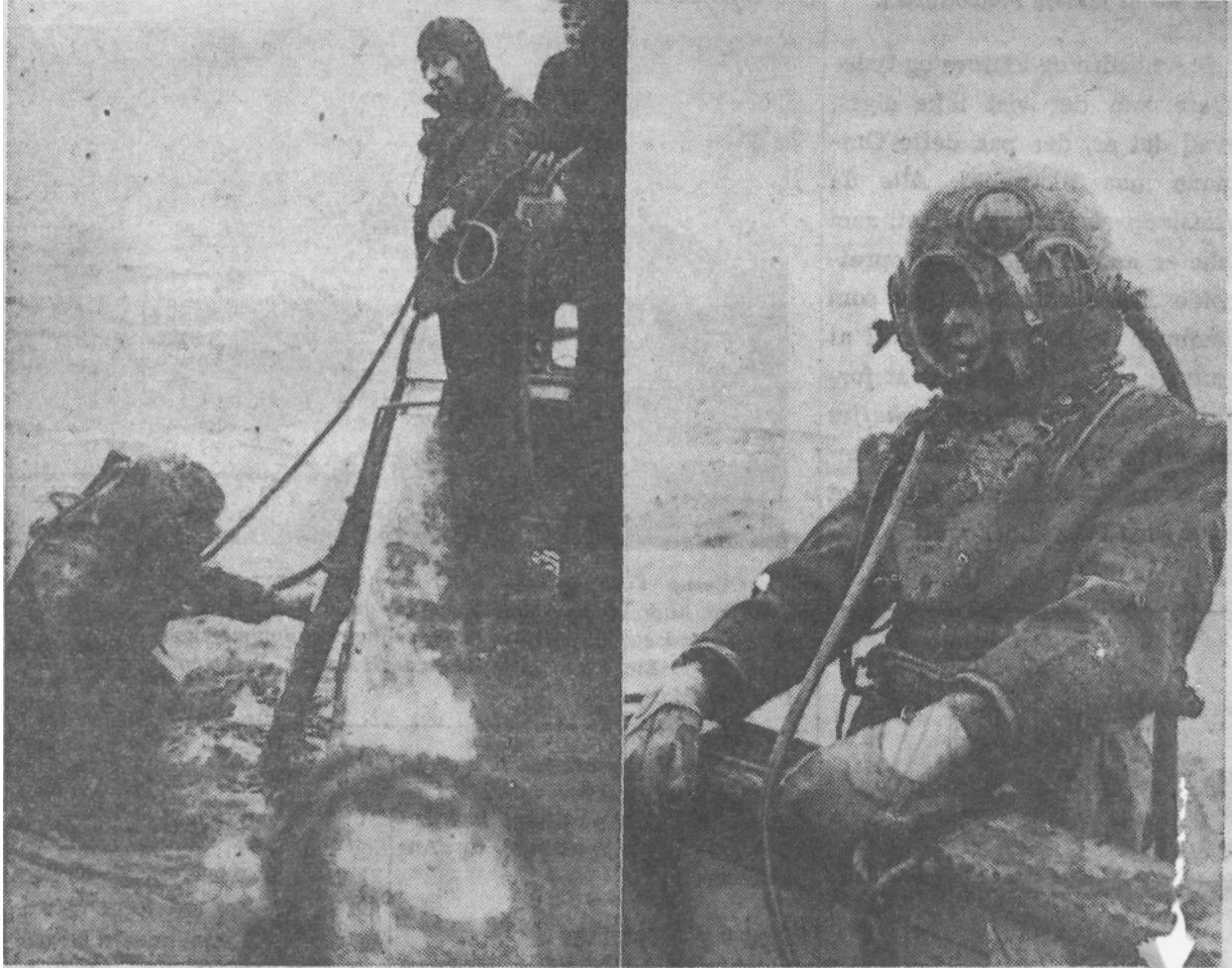
Dykker K. Hessing holder Hvilepause og har faaet sin Pibe ind i Hjelmen. — Dykkeren gaar ned, medens Linefører Ovesen ordner Livline og Luftslinge.
