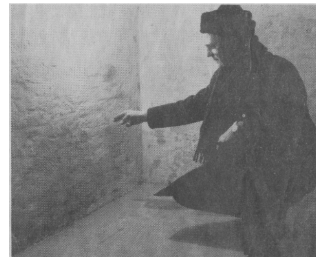
Aage Egholm viser stedet i muren, hvor Lorentzen med en stoppenål begyndte sin tunnelgravning.
