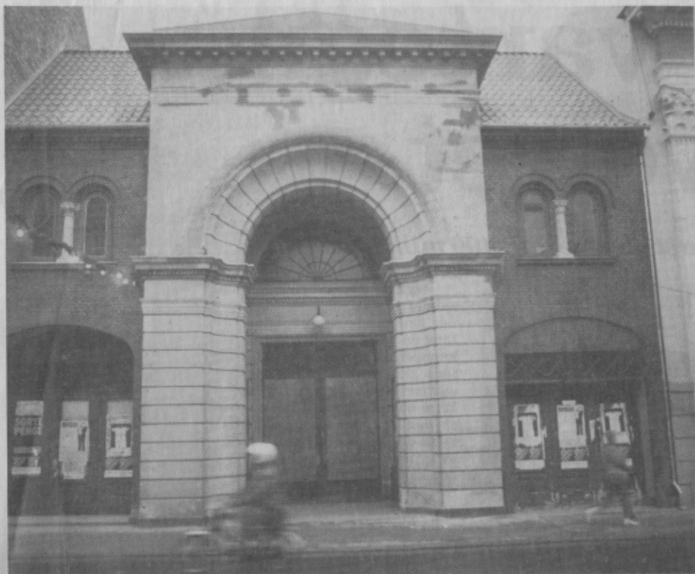
Den tidligere biograf i Borgergade har været igennem en gennemgribende renowering og har bl.a. fået lagt nyt tag. Indvendig er der installeret centralvarme, indlagt vand og el-installationerne er lagt om. (Foto: Lars Juul)
