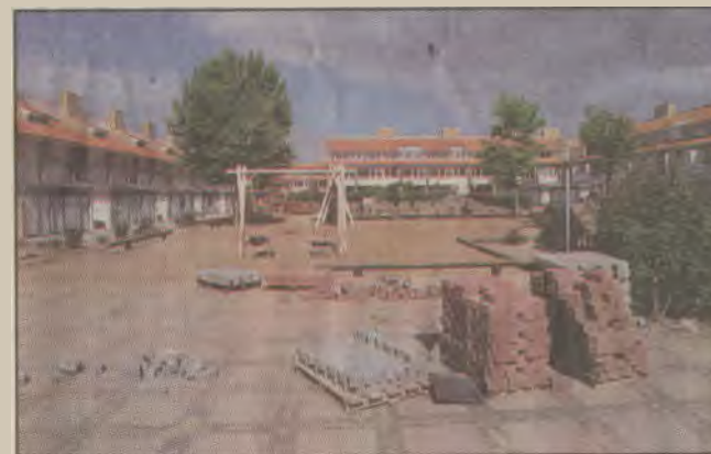
Den store centrale plads renoveres også.
