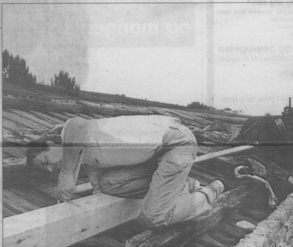
Tømrer Dan Henriksen og hans kolleger tilpasser tagspærene i hånden. Maskiner kan nemlig ikke lave de såkaldt franske låse, som er en metode, der bruges til at sammenføje de tykke træstolper uden brug af søm og skruer.
