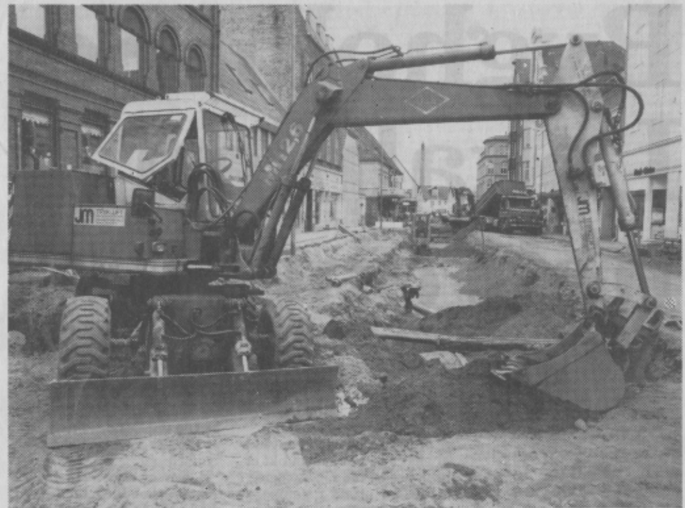
De sidste dage er det gået stærkt med at grave ud i Nørregade. Nedlægningen af de nye kloakrør er lidt forsinket, og det skal hentes ind. (Foto: Martin Ravn)
