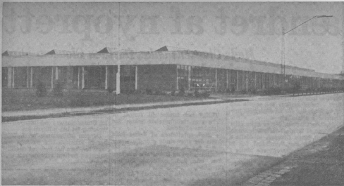
Den ny Rank Arena-fabrik i Horsens er en af de mest moderne - hvis ikke den allermoderneste - radiofabrik i Europa.
