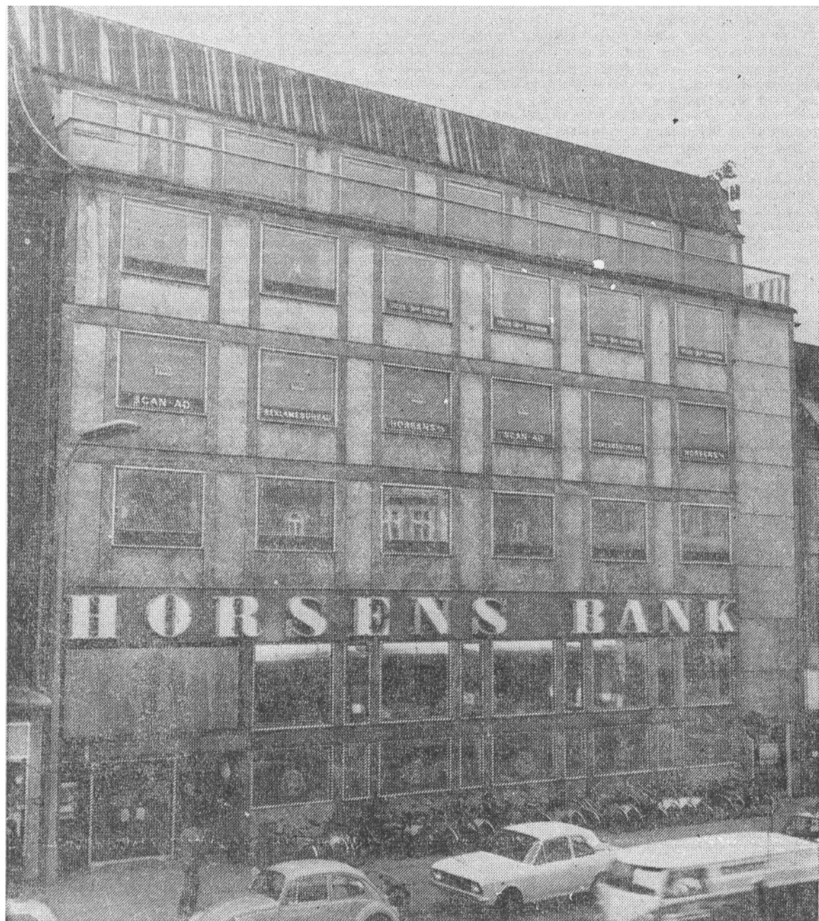
En moderne bankbygning - Horsens Bank på Søndergade.
